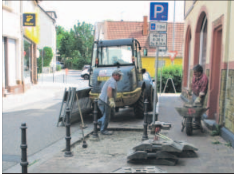
Mitarbeiter der Gemeindewerke haben letzte Woche mit notwendigen Reparaturen an der Stromleitung begonnen.
