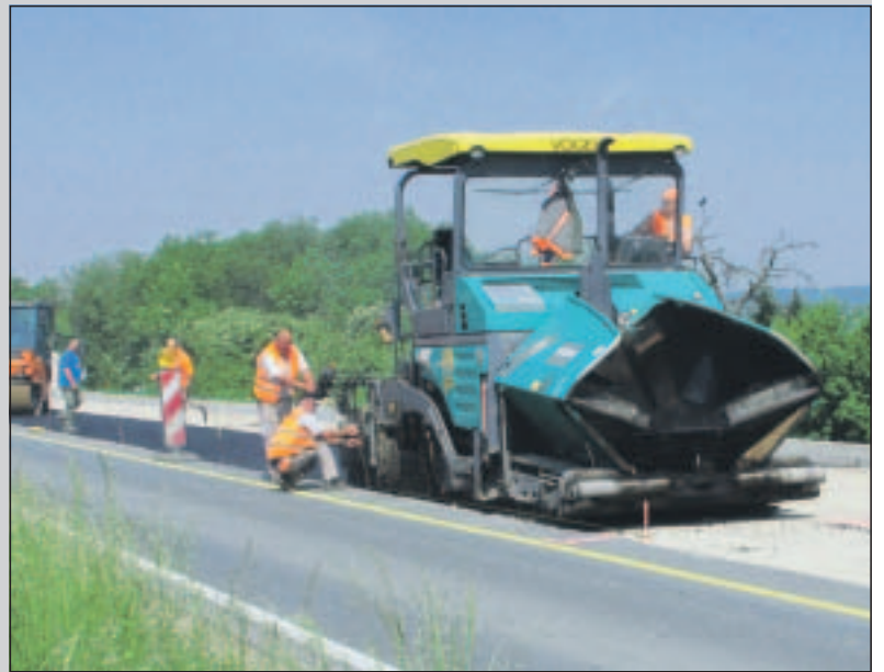
Der Stand der Tiefbauarbeiten in der Budenheimer Parkallee war Thema.
