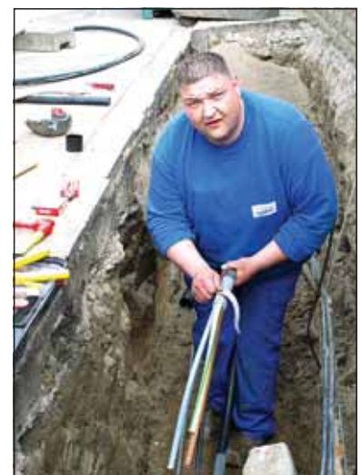
Ein Mitarbeiter der Gemeindewerke Budenheim bei der Schadensbehebung.
