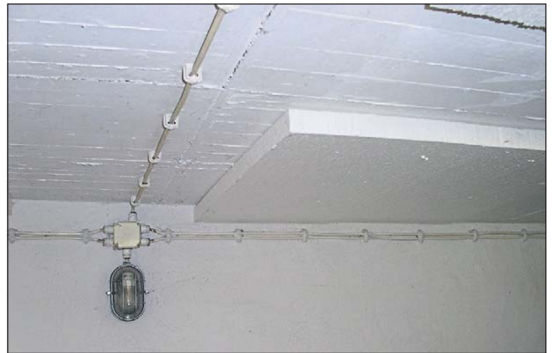
Zehn Zentimeter sollten es bei einem guten Dämmstoff mindestens sein. Das Anbringen in Schichten erleichtert das Einarbeiten von Rohren und Anschlüssen. (Foto: B. Andre)
