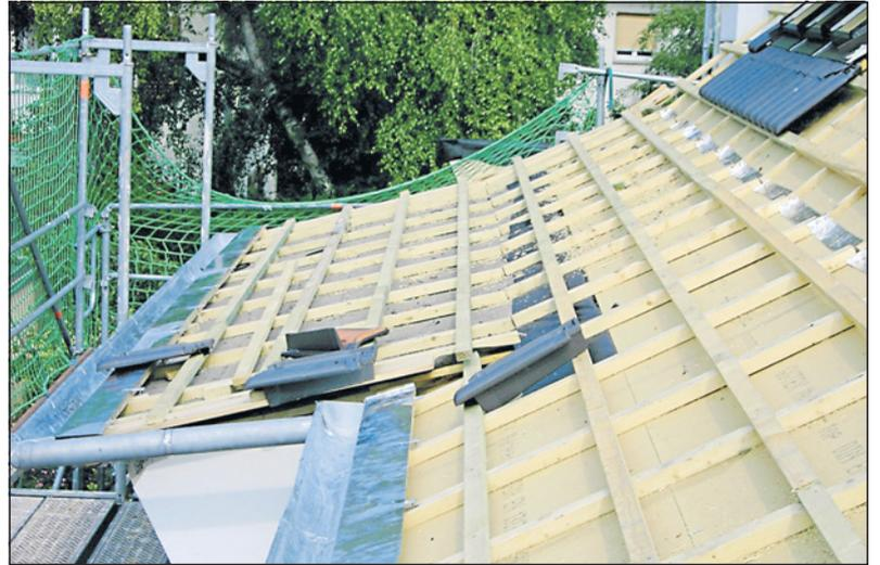
**Holzweichfaserplatten sind eine empfehlenswerte Alternative zur Unterspannbahn: Sie sind stabiler und bieten einen zusätzlichen Dämmeffekt.** (Foto: VZ RLP)
