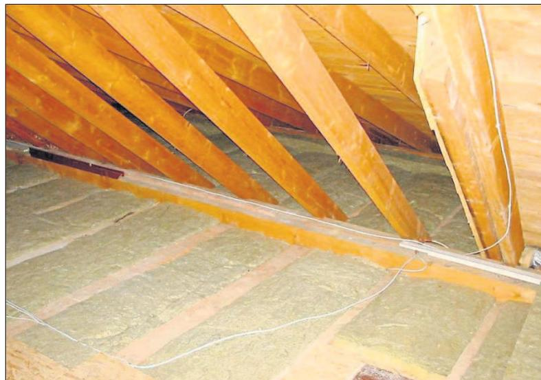
**Holzbalkendecken lassen sich von oben optimal mit Mineralwolle zwischen den Deckenbalken dämmen. Durch die Abdeckung mit OSB-Platten wird der Dachraum wieder begehbar.**
