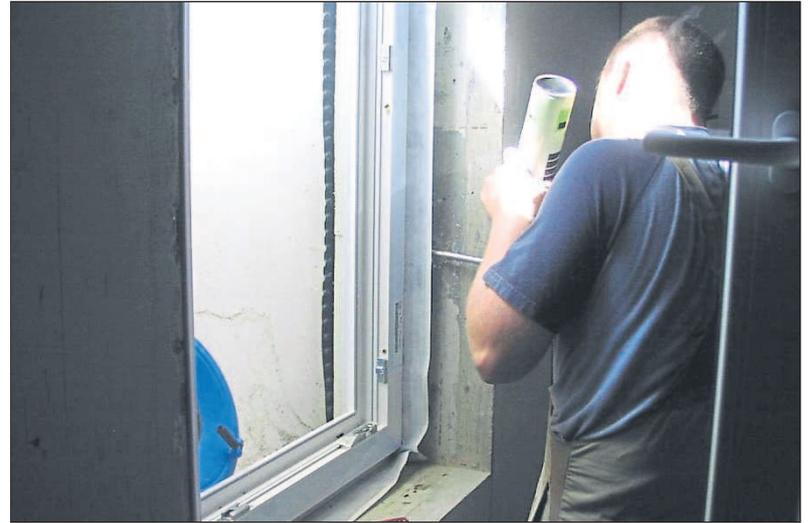
Montageschaum reicht beim Einbau neuer Fenster nicht aus – der Rahmen muss luftdicht in der Leibung verklebt werden.
