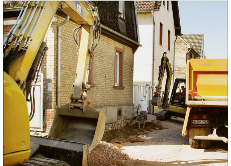
Ausbau der Langstraße angelaufen: Am 22. August begannen die Arbeiten zum Ausbau der Langstraße. Die bauausführende Firma Hebau GmbH wird auch samstags arbeiten, damit die geplante Fertigstellung bis Weihnachten möglichst erreicht wird.
