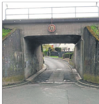
Bahnunterführung aus Blickrichtung Am Heidesheimer Weg in Budenheim. (Foto: Gemeindewerke Budenheim/Oliver S)
