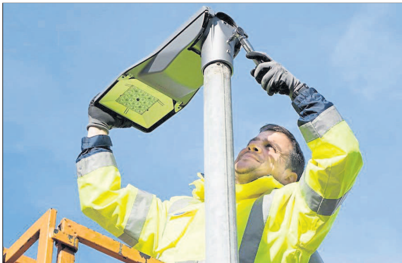
Montage eines LED-Lampenkopfs auf einen alten Beleuchtungsmast durch Mitarbeiter Tony Koussa von den Gemeindewerken.
