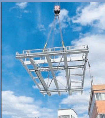
Einheben einer Stahlbauvormontage, gefertigt von »Stahlbau Schmitt«, in eine Industrieanlage.
