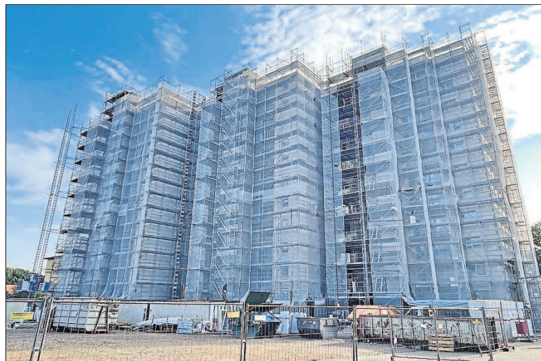
In der Römerstraße 51-55 werden unter anderem neue Aufzugsanlagen installiert. (Foto: Wohnungsbaugesellschaft Budenheim)
