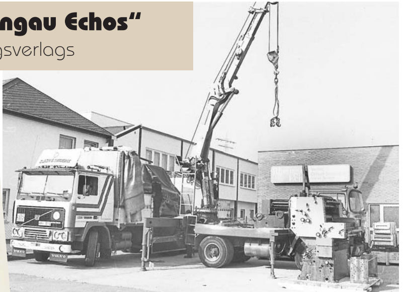
Mit der Rotationsdruckmaschine, die aus Schweden angeliefert wurde, war es möglich, in einem Durchgang 48 Seiten des „Rheingau Echos“ zu drucken. Über den Sammelhefter wurden die einzelnen Produktteile zu einer Ausgabe zusammengetragen für die Gesamtausgabe.
